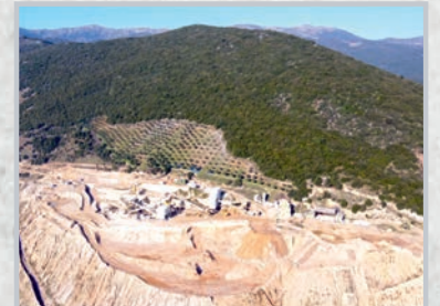
Cihatlı Agregası Tesisi
